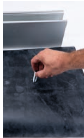
4. Anker einsetzen. Ankerhöhe genau einstellen.
