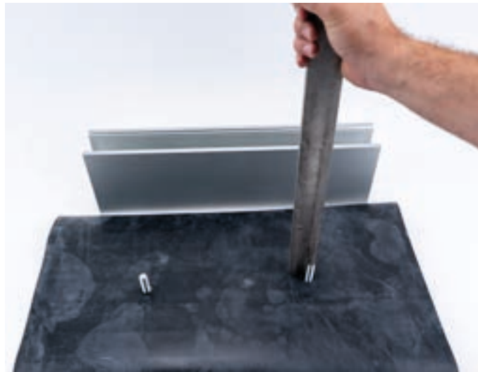
3. Richtige Dicke des Ausgleichsblocks bestimmen, um erforderliche Kompression ( \geq 30\% ) zu erreichen. Bei unebenem Untergrund Dicke variieren; max. Füllung zwischen Block und Untergrund = 1 mm.
