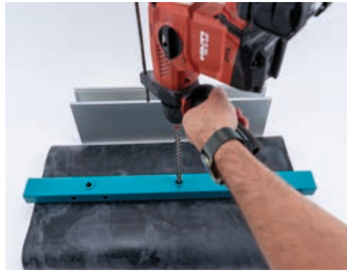
2. Loch bohren. Für präzise, senkrechte Platzierung der Flanschmutter SPARQ-Bohrschablone verwenden.
