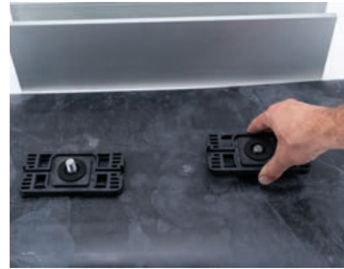
5. Ausgleichsblock über den Anker schieben.
